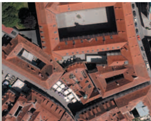
Abb. 67 Südof Priesterseminar mit mittelalterlicher Stadtmauer
