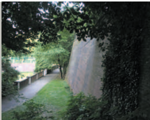
Abb. 45 Nördliche Befestigungsmauer beim Paulustor
